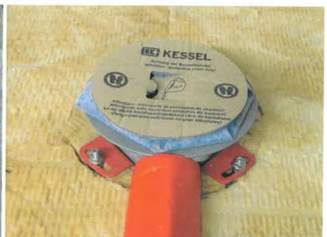
Oben: Stockschrauben in "Setzungsämpfer" befestigt.
